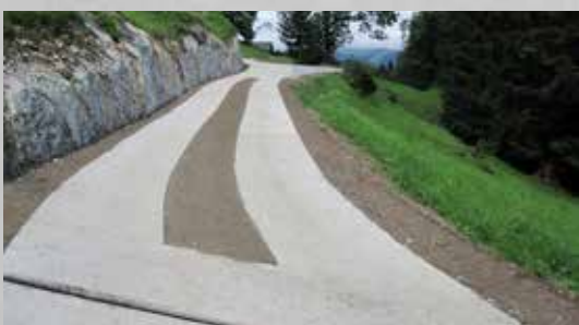
Spurwege, Oberfläche Besenstrich und geprägt
