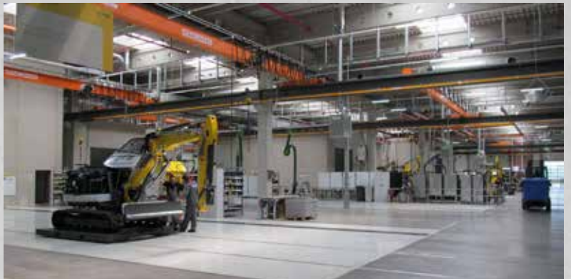
Industriehalle 50000 m 2 nur mit Fibrofor High Grade bewehrt, fugenarm
