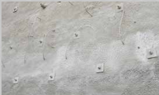
Vernagelte Spritzbetonwand
