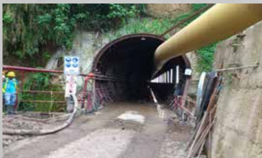
Spritzbeton im Tunnelbau/Bergbau
